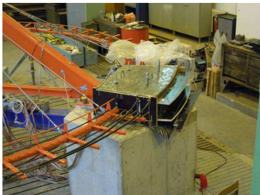
Obr. 3 Betonáž kotevního bloku
