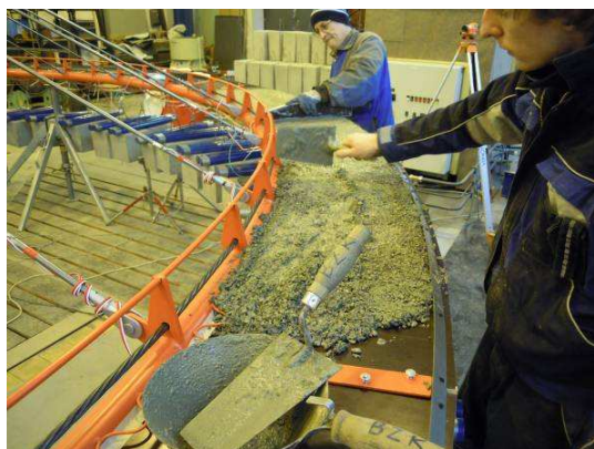
Obr. 5 Betonáž mostovky
