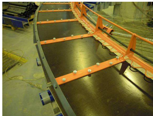
Obr. 4 Bednění mostovky - sřahovací prvky
